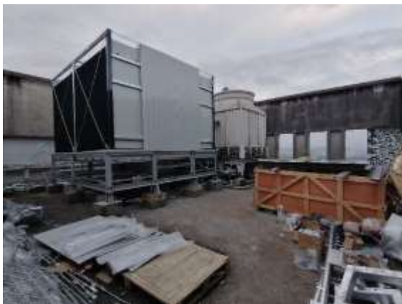
【圖 11】搭建新的空調過濾塔 拍攝於 2023/6/18
